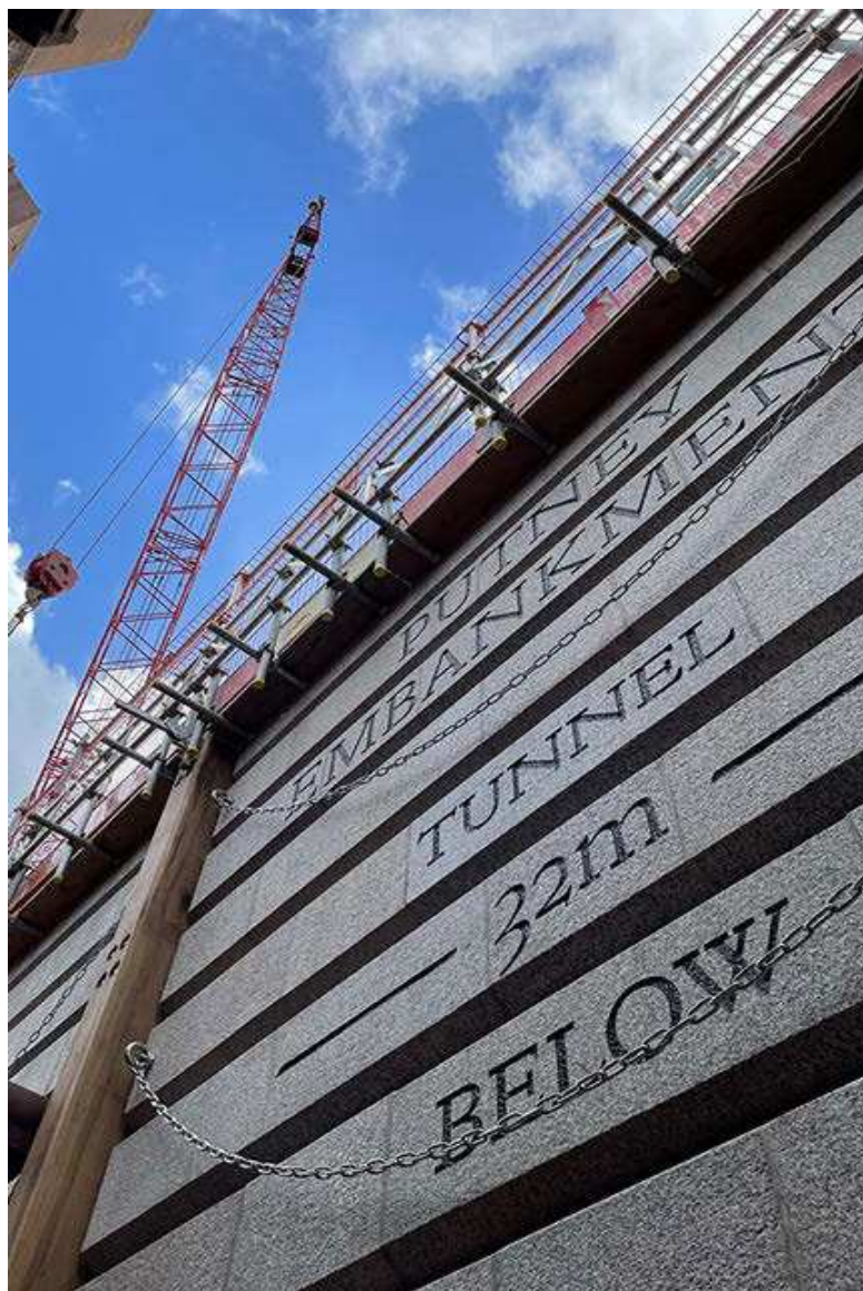
Se trata de la mayor modernización que ha experimentado el alcantarillado de la ciudad.
