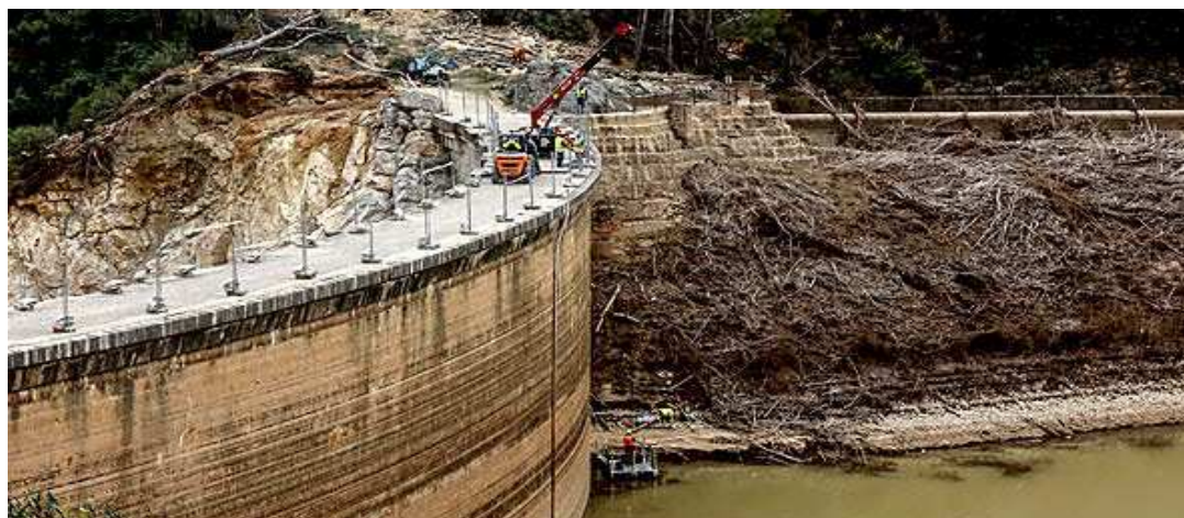
Las obras de reparación de la presa de Buseo, en Valencia, se alargarán durante meses. Europa Press
